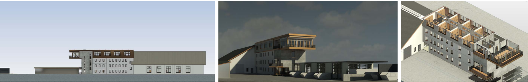
Zubau und Aufstockung bestehendes Werkstätten- und Bürogebäude der ÖBB-ASC in Bludenz
