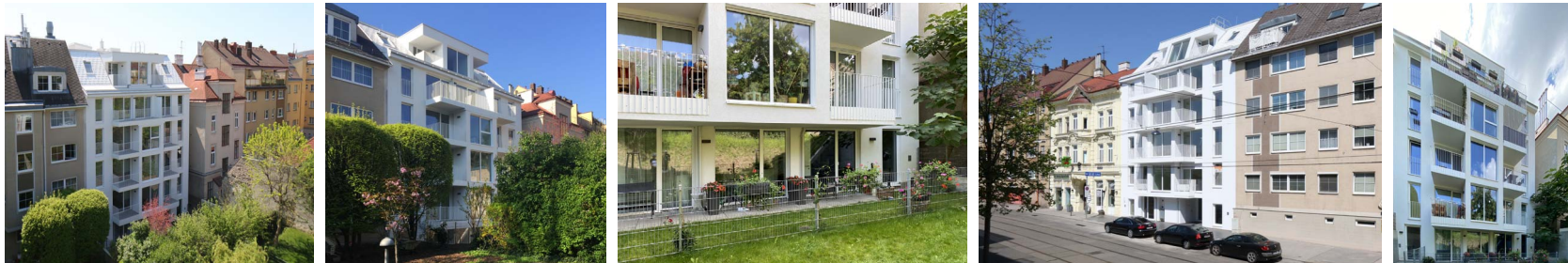
Wohnhaus Linzer Straße 248, 1140 Wien 19 Wohneinheiten zw. 35 bis 55 m 2 Wohnnutzfläche, Gewerbefläche im Sockelgeschoß
