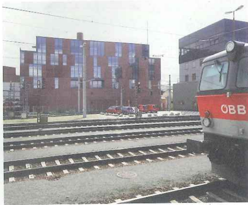
Eine schlichte, aber innovative Fassade aus Fertigteilen. Foto/Bernhard Bachmann
